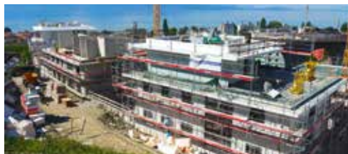
Quartier du Vallon de la Paudèze en cours de construction.
