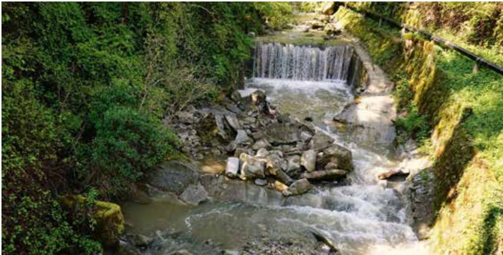
La libre Paudèze juste avant d'être mise sous tube et canalisée.
